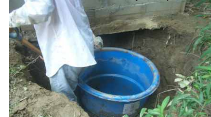
Figura 27 Colocación en un hoyo del tambor colector de lixiviado.
