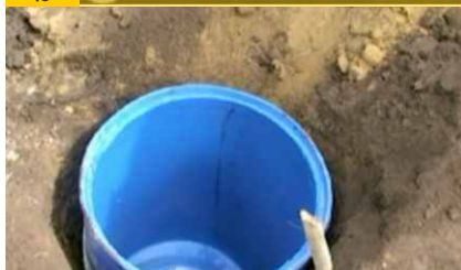
Figura 17 Colocación del tambor en el hoyo para coleccionar el lixiviado.
