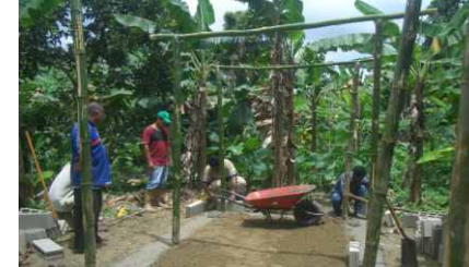
Figura 25 Preparación del área con una ligera pendiente.
