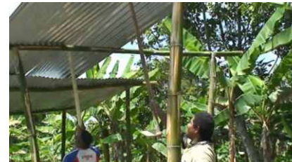
Figura 28 Colocación del techo.
