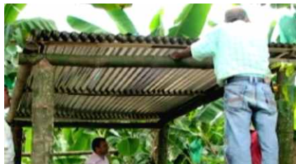
Figura 18 Colocación del techo.
