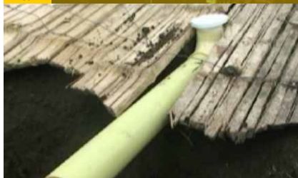
Figura 16 Colocación de esterilla y tubo plástico de inodoro.
