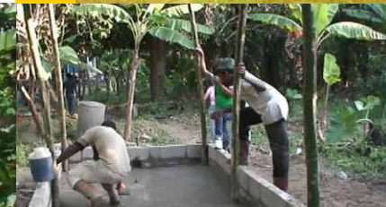
Figura 29 Aplicación de sellador comercial.
