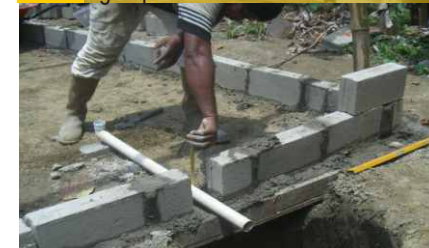
Figura 26 Pegado de bloques de cemento, colocación de esterilla y tubo plástico
